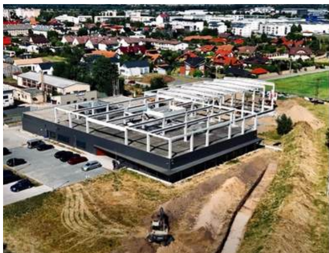
Obraz 1. Obecne prace przy rozbudowie zakładu
